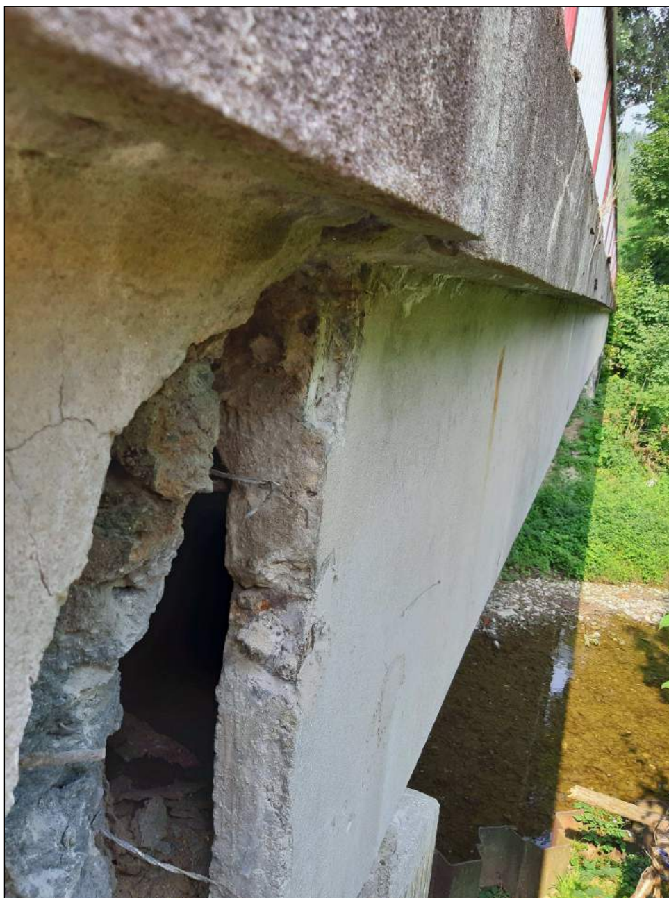
Obr. č. 5 - pohled na odhalenou část nosníku a římsu
