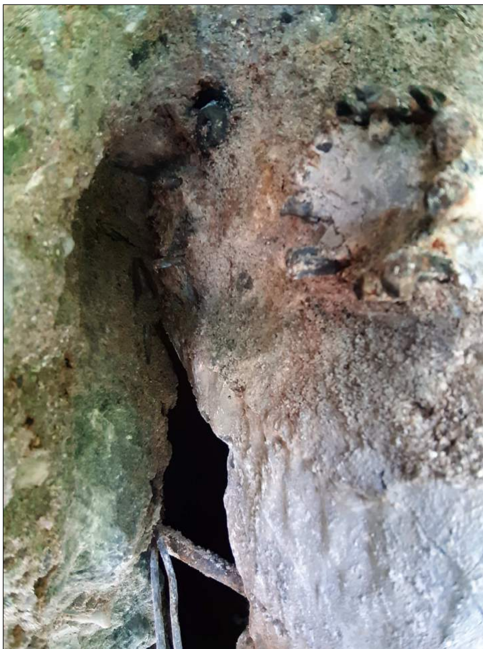
Obr. č. 6 - pohled na odhalenou část nosníku a kotevní lana
